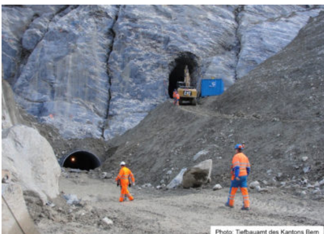
Abb. 9: Arbeiten für den Bau eines Entwässerungsstollens
