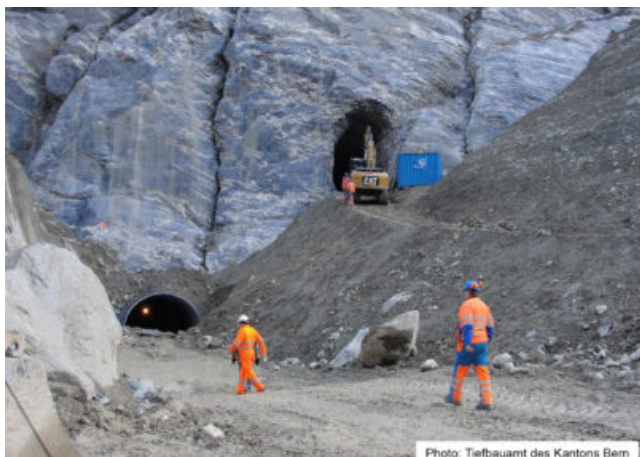
Fig. 9 – Entrée du tunnel de drainage d'un lac supra-glaciaire
