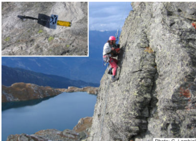
Fig. 4 – Installation de capteurs de température dans la paroi rocheuse du Col de Chassoure (Verbier-Nendaz).
