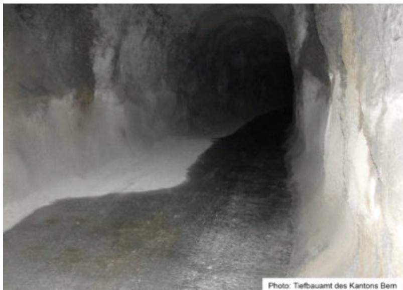
Fig. 10 – Tunnel de drainage du lac supra-glaciaire du Fig. 11 – Le tunnel de drainage réalisé pour vider le lac supra-glaciaire du Glacier de Grindelwald limite l'accumulation de l'eau. terminé.
