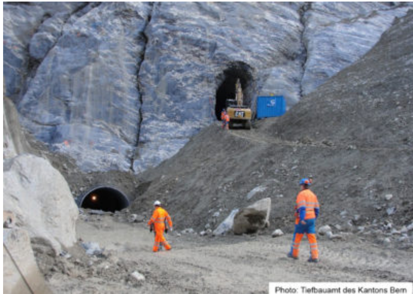
Fig. 9 – Travaux en vue de la réalisation du tunnel de drainage du lac supra-glaciaire du Glacier de Grindelwald .
