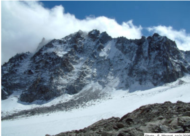
Fig. 3 – La face nord du Portalet (VS) semble avoir perdu sa carapace de glace dans la dernière partie du 20ème siècle. Aujourd’hui, la paroi n’est plus protégée par de la glace. La roche fracturée dégèle, provoquant d’incessantes chutes de pierres qui viennent s’amonceter sur la rive droite du glacier d’Orny.
