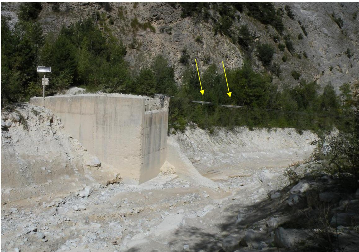
Fig. 5 – Radar placé au-dessus du chenal au niveau du check dam 10 dans l'Iligraben.
