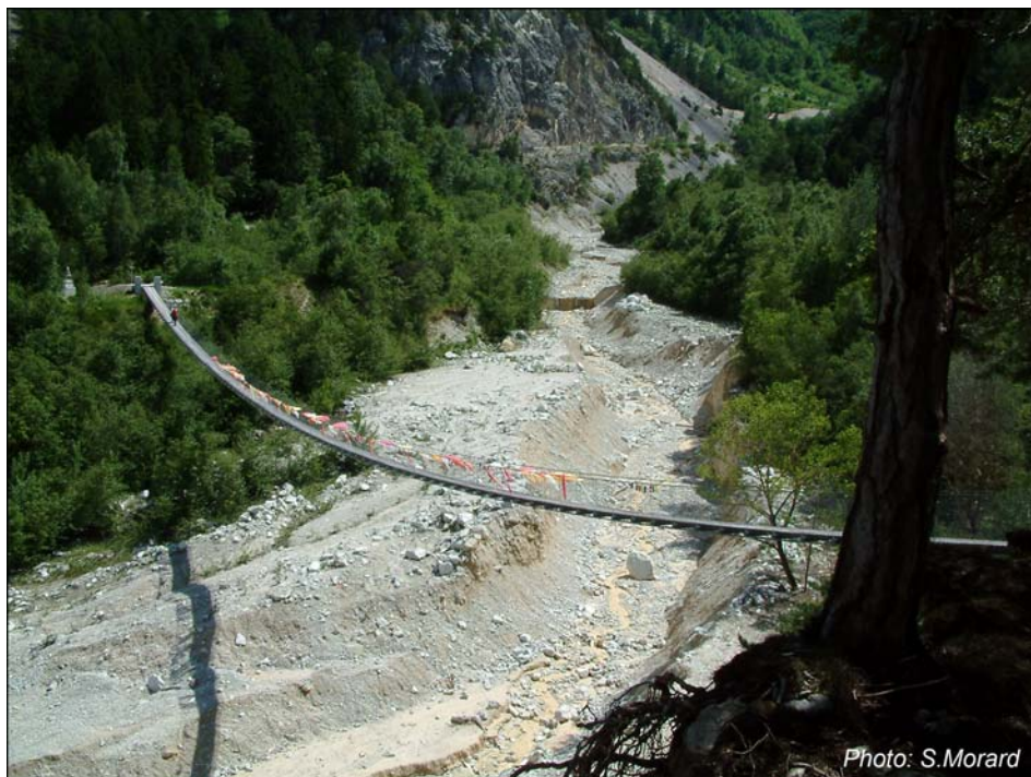
Fig. 4 – L'Illbach (VS) est un tout petit torrent, mais chaque année il crache en moyenne 250'000 m 3 de boue, de cailloux et de blocs de taille parfois impressionnante (notez le bloc sous le pont bouthanais). L'entaille profonde du lit du torrent au centre de l'image est consécutive à un unique événement majeur de lave torrentielle.
