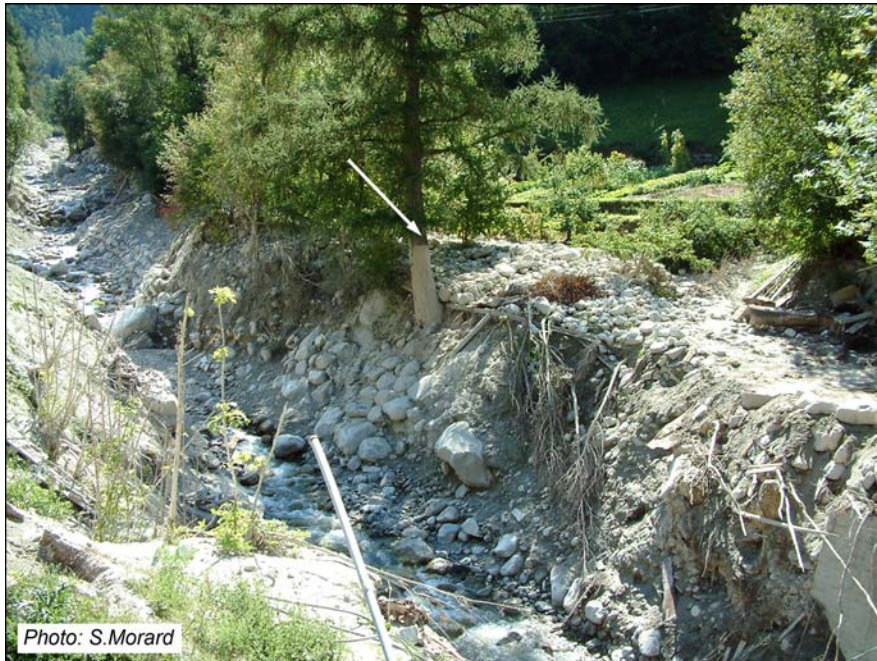
Fig. 5 – Chenal après le passage de la lave torrentielle du Durnand en juillet 2006 (VS). Notez la hauteur limite du dépôt de boue sur le tronc d'arbre.
