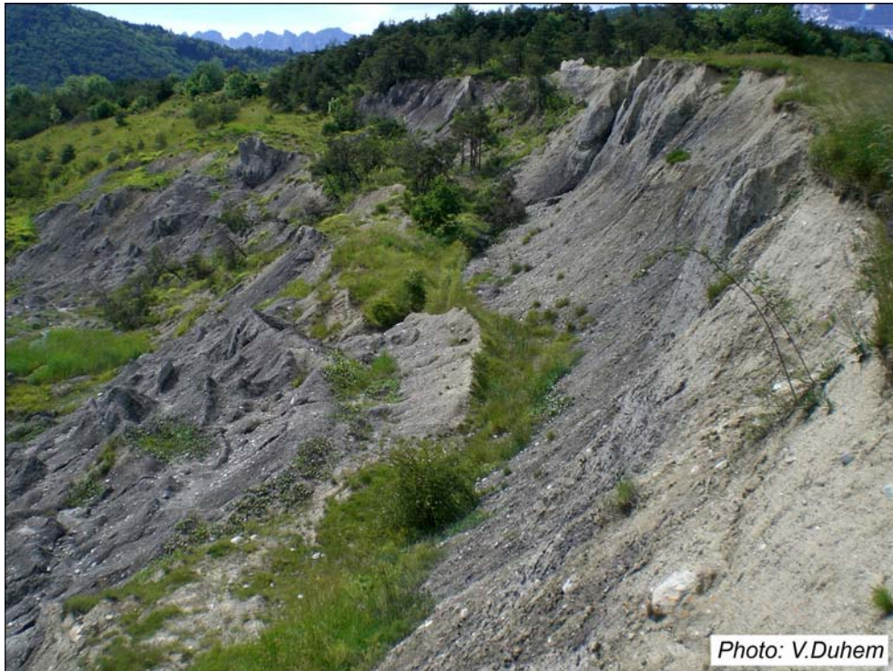
Fig. 3 – Niche d'arrachement du glissement de l'Harmalière, Isère.
