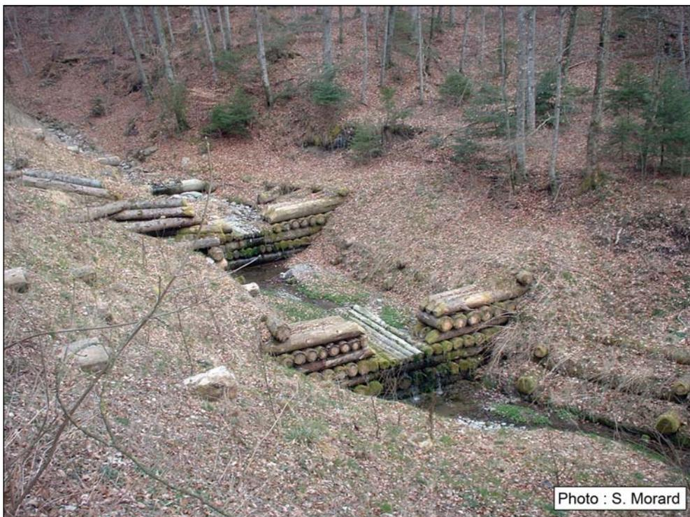
Fig. 4 – Seuils artificiels dans un torrent (Fribourg).
