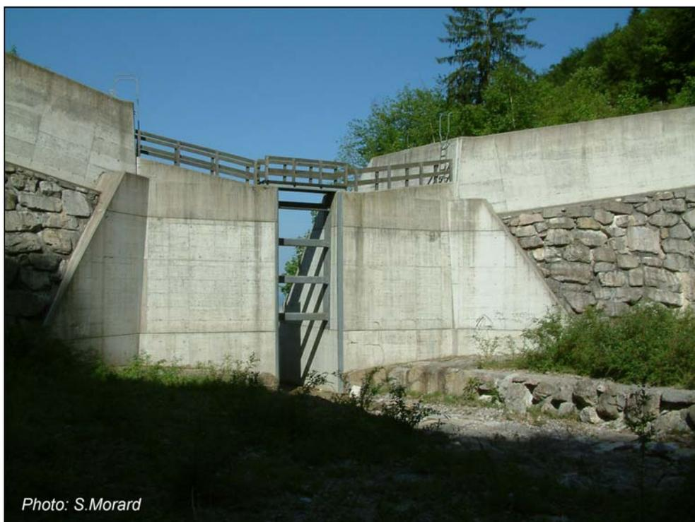
Fig. 5 – Ouvrage de protection à effet "brise-lave" contre les laves torrentielles (Villeneuve, VD).
