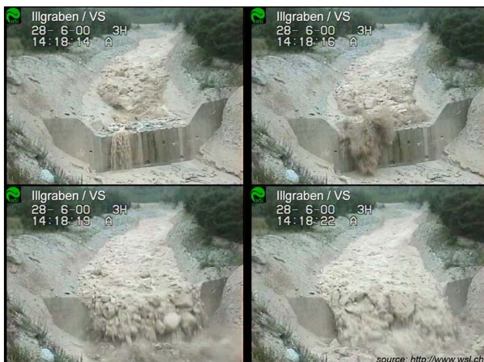
Fig. 3 – Passage d'une importante lave torrentielle dans le chenal de l'Illgraben (VS) le 28 juin 2000. Le chenal mesure environ de 20m de large et le mur 6m de haut. Entre la première et la quatrième image, il ne s'est écoulé que 8 secondes ! Notez la taille des blocs transportés (source : http://www.wsl.ch ).
