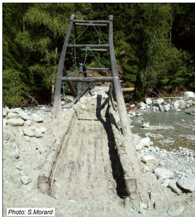
Fig. 6 – Les matériaux transportés par la lave torrentielle du Durnand (volume de 35'000 m 3 ) le 25 juillet 2006 à 19h30 ont obstrué le cours d'eau de la Dranse à l'endroit où une passerelle la franchit. A l'aval, la lave torrentielle a arraché le pont ferroviaire et les rails du train, faisant également dérailler le train qui s'apprêtait à franchir le pont.
