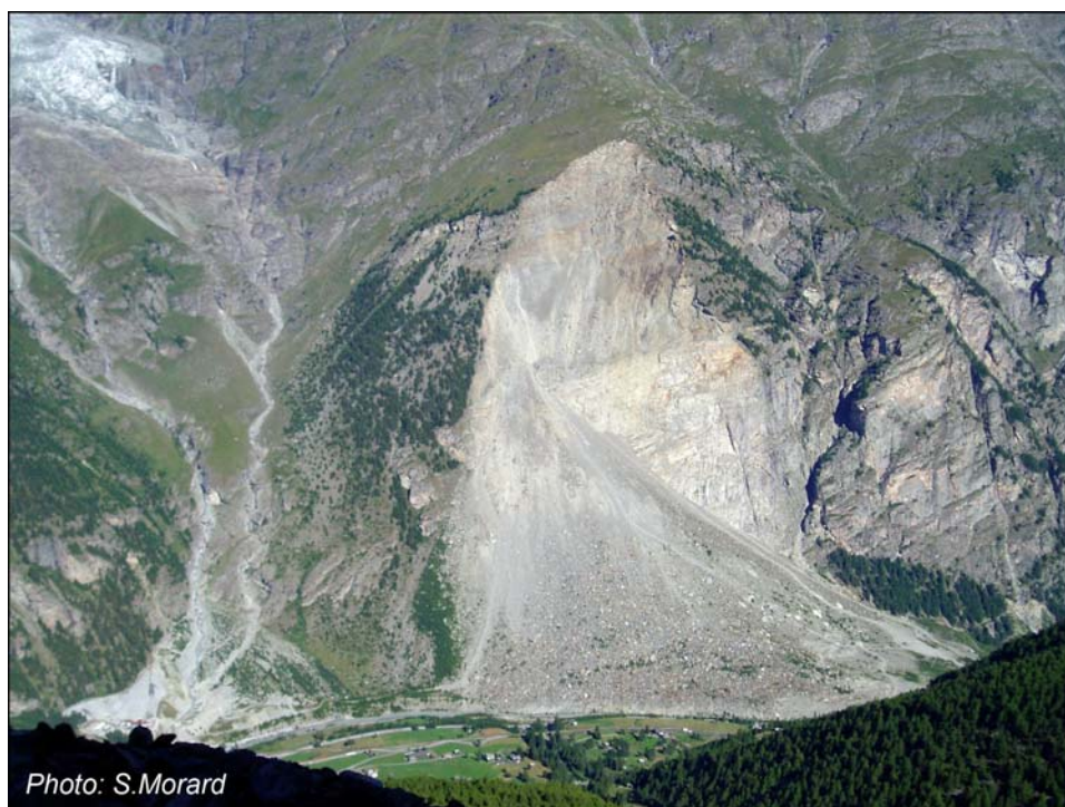
Fig. 5 – Exemple d'une rupture d'un pan de paroi : l'éroulement de Randa (VS) de 1991 (vol. 30 mio de m 3 ).
