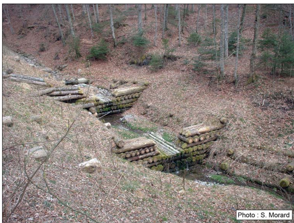
Fig. 4 – Seuils artificiels dans un torrent (Fribourg).
