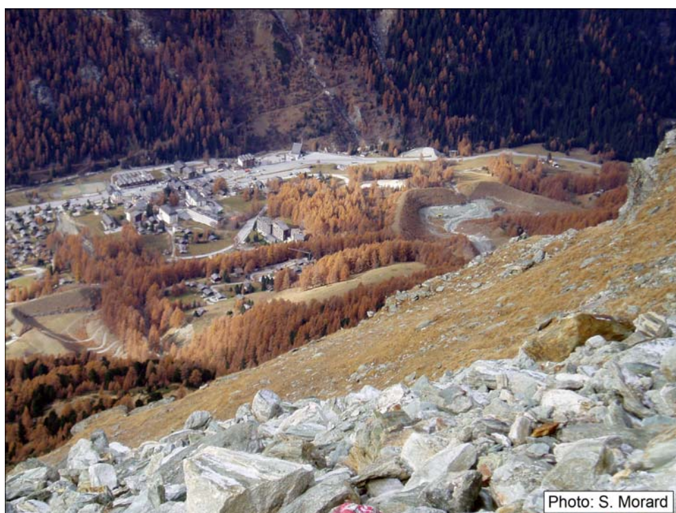
Fig. 6 – Digues de protection contre les avalanches (Zinal, VS).
